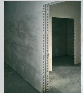
ПГП используются для монтажа межквартирных перегородок, который выполняется обычно в два слоя
