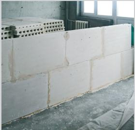
В помещениях с сухим режимом эксплуатации (спальни, кабинеты, прихожие, коридоры) применяют обычные ПГП.
