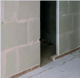
В помещениях с влажным режимом эксплуатации (санузлы, ванные) применяют влагостойкие ПГП, в которые вводятся гидрофобизаторы, препятствующие накоплению влаги.
